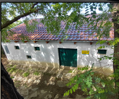
Umfangreiche Dachsanierung am Seitweg-Presshaus in Hadres Seite 3
