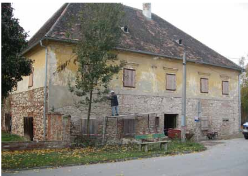
Die Renovierungsarbeiten am denkmalgeschützten Pfarrhof Mailberg sind im Gange und werden von der Bau- und Transport GmbH Brabenetz durchgeführt.
